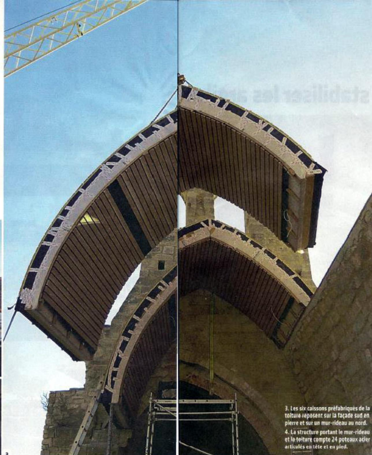
3. Les six caissons préfabriqués de la toiture reposent sur la façade sud en pierre et sur un mur-rideau au nord.
