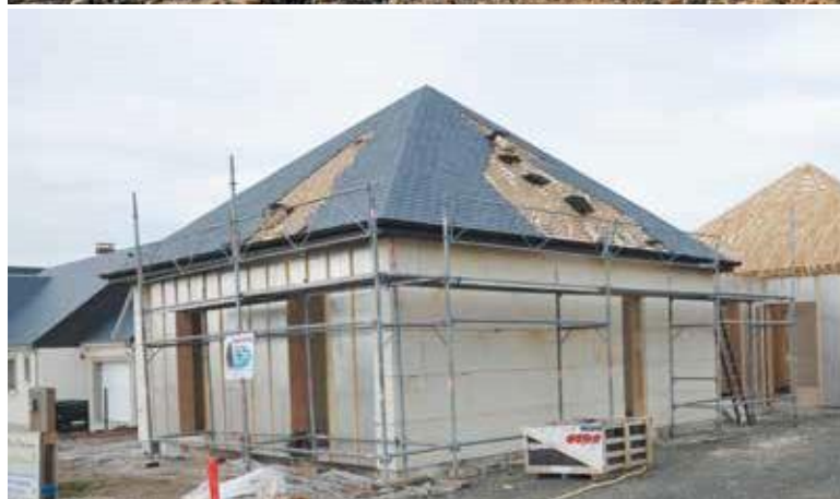
Les murs à ossature bois sont associés aux murs en pierre.
